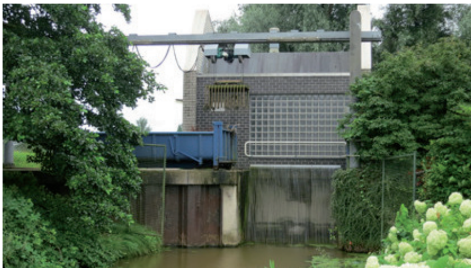
foto: gemaal Snel & Polanen, aan de Polanerzandweg 13 te Woerden
